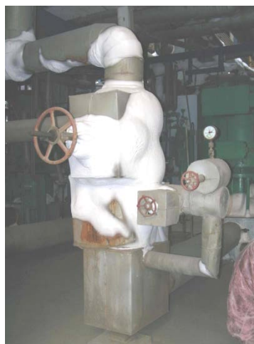
硬质系统多采用现场注射发泡的方法处理异形部件，存在较大漏冷风险。
