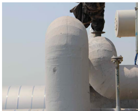
硬质系统需要专门安装防潮层，防潮层的选材和施工质量几乎决定了保冷系统的成败。
